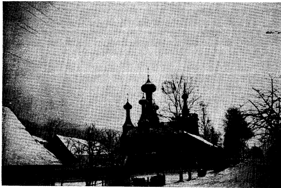
Лємковска церковь в сєлі Климковка, повіт Горлицы, побудована в 1914 року.
